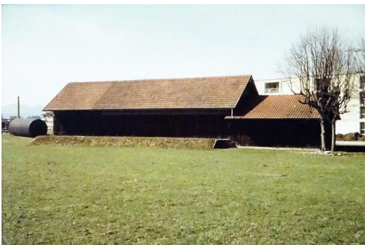
Erstes Schützenhaus an der Bresteneggstrasse, erbaut 1906, Scheibenstand im Wald östlich der Wynentalstrasse.
